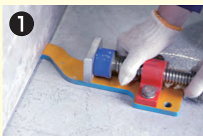
①床面の柱底面の隙間へ フックを差し込む
